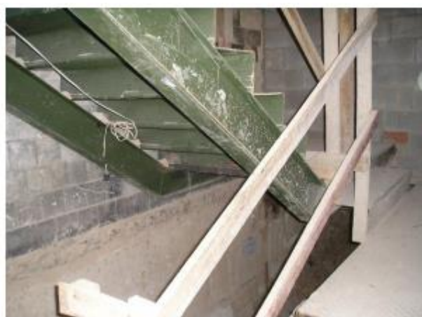
a) Estrutura da escada
