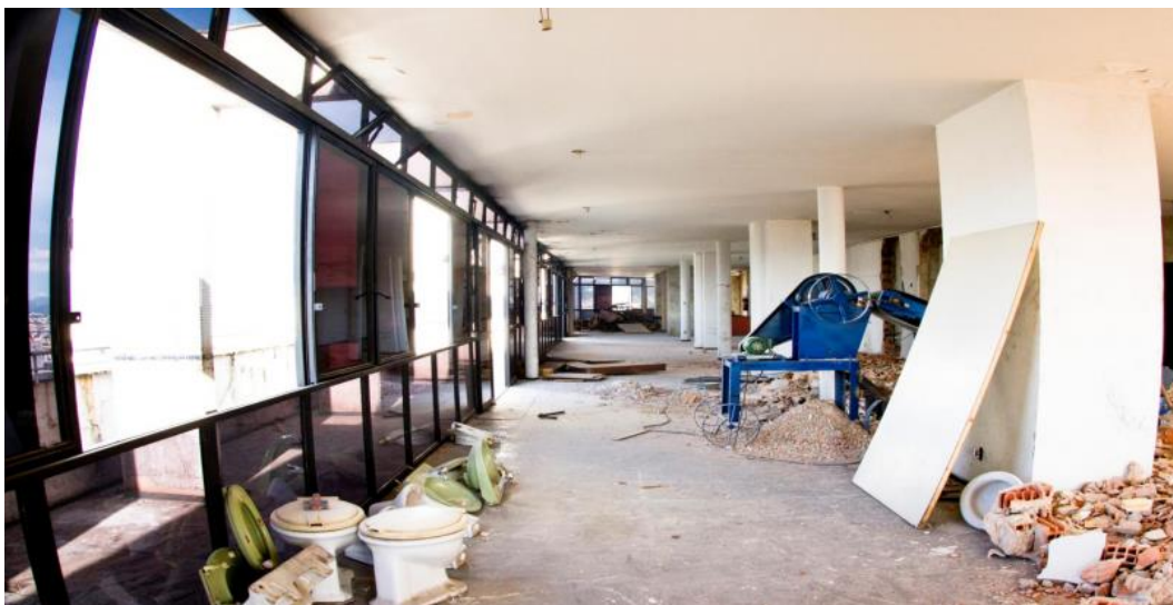
Figura 12 - Processamento do entulho gerado na obra
