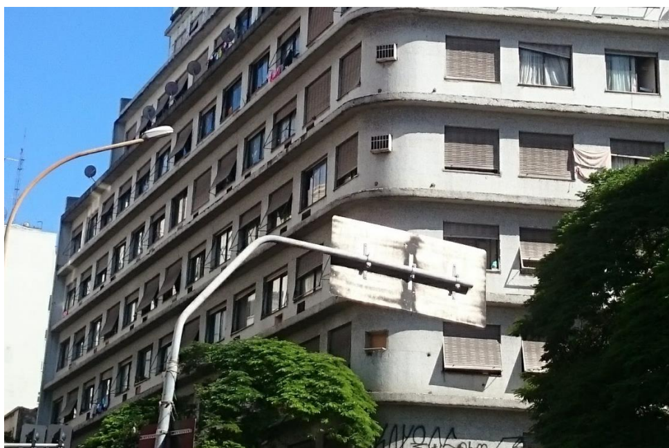
Figura 45 - Janelas originais nas fachadas principais do Lord Palace Hotel.
