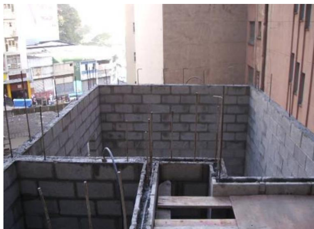
Figura 6 - Escada De Incêndio Construída No Edifício São Paulo
