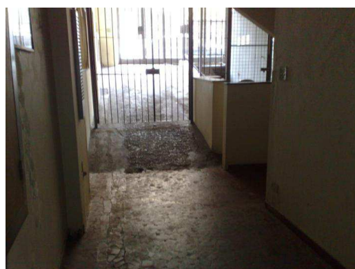
Foto 3 – Detalhe da rampa do sub solo
