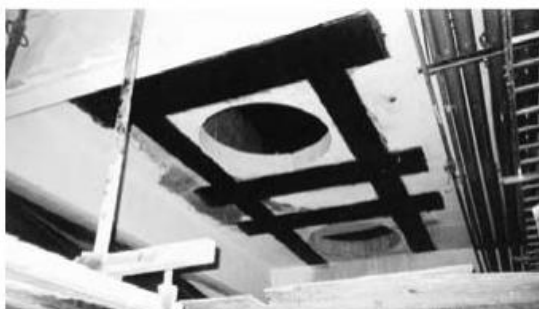
Figura 2 – Reforço de fibras de carbono em laje perfurada
