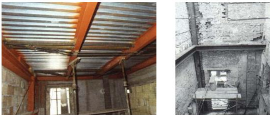
Figura 33 - Novo teto em aço e nova estrutura metálica para sustentação de estruturas
